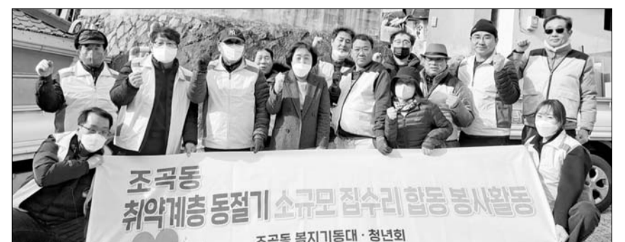
순천시 조곡동 복지기동대는 지난 5일 지역 청년회와 함께 동절기 취약계층 주거개선을 위해 합동 집수리 봉사활동을 펼쳤다. 집수리 대상자는 노후주택에 고령의 노인이나 장애인 자녀가 함께 거주하며 문이 없는 화장실로 인해 겨울철 동파 위험에 노출되어 있었으며, 주방 싱크대 역시 내려앉아 집수리가 매우 시급한 상황이었다. 신성식 복지기동대장 외 8명, 김광수 청년회장의 6명의 회원들은 화장실 문 설치 등 수선과 노후 싱크대 교체, 급경사 계단 안전 손잡이 설치 등 거동이 불편한 고령의 어르신들을 위한 주거 환경 개선을 위해 한파가 지속되는 추운 날씨에도 구슬땀을 흘렸다. 신성식 복지기동대장은 "대원들이 직접 어려운 가정을 찾아내고 봉사활동까지 마무리해주어 보람을 느낀다"며 "앞으로도 조곡동 어려운 이웃을 위해 복지기동대가 앞장서겠다"고 말했다. /순천=조순의 기자
