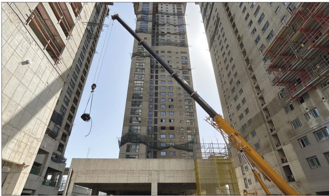
광주화정아이파크에서 8개동 전면 해체를 앞두고 타워크레인 설치를 위한 자재 반입 작업 사진 /뉴스시스
